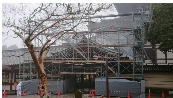
東大寺仮設工事
