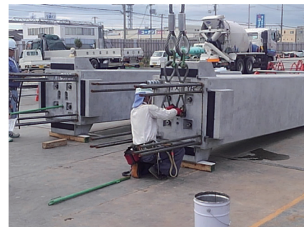
現場作業風景
