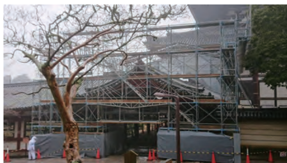
東大寺仮設工事
