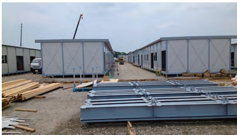
熊本仮設住宅建設風景
