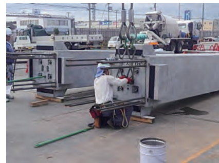
現場作業風景
