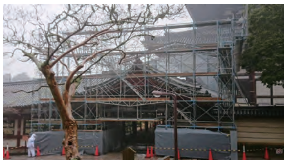
東大寺仮設工事
