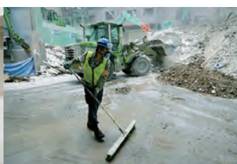
工場内は隅々まで清掃、 整理整頓が行き届いています。
