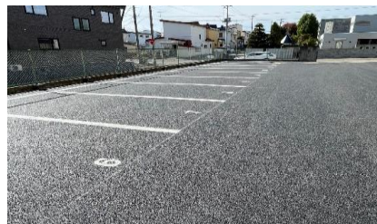
駐車場のアスファルト舗装現場写真
