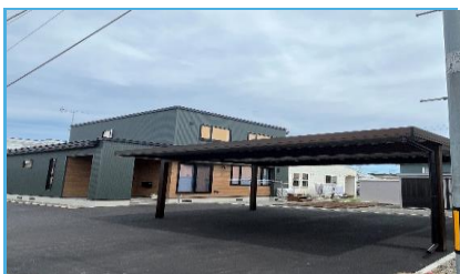
アスファルト舗装とカーポートの設置 現場写真
