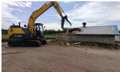
解体工事作業風景 機械解体
