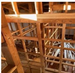
解体工事作業風景 内部解体
