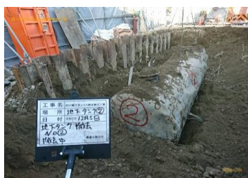
ガソリンスタンド解体
