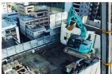
10階建て階上解体
