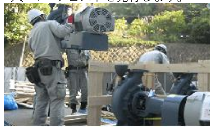
08. 搬入据付作業2 クレーン等を使用して機器を搬入します（ポンプ搬入時状況写真。）
