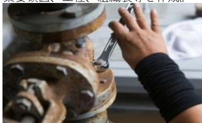
05. 解体搬出工事 既設機器の撤去搬出作業を行います。
