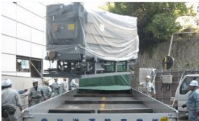
08. 搬入据付作業1 大型クレーン等を使用して機器を搬入します（冷凍機搬入時状況写真。）
