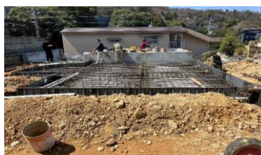
現場作業（基礎）
