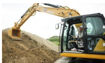
現場作業（掘削）
