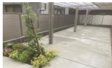
完成現場（カーポート）
