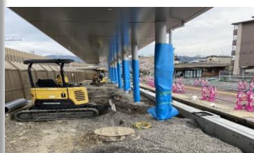
現場作業（駅整備）
