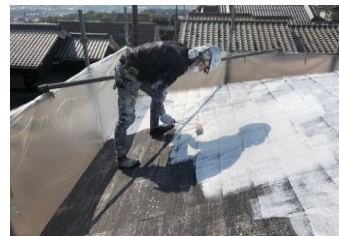
屋根塗装作業
