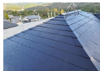
屋根 塗替え工事
