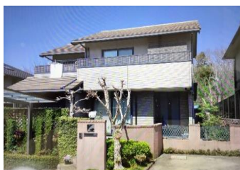
一軒家 塗装工事
