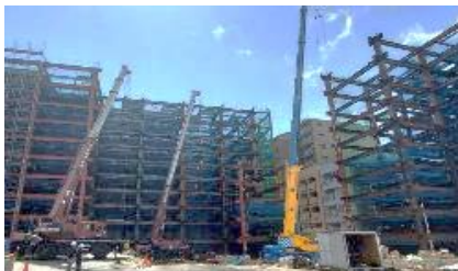
鉄骨建方工事 鉄 骨は強度が高く、単位重量が軽いことから、大空間建築物の建設が多い
