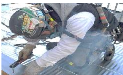
デッキ工事 作業風景 鉄 骨造の建物における床材を形成する工事 （床版工）
