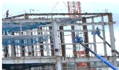
鉄骨建方工事 作業風景 工 場で製作・加工された鉄骨を現場へ持ち込み、部材同士を接合し組み立てる
