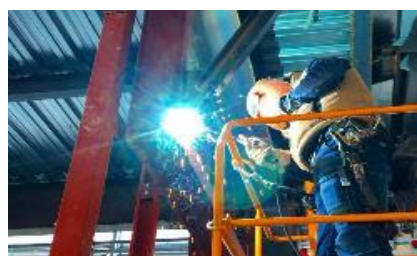
鍛冶工事 作業風景 仕 上がり丁寧さ、クオリティの高さが求められる要となる工事（鍛冶工）
