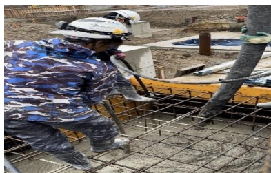
★現場作業風景★
