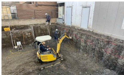
★現場作業風景★
