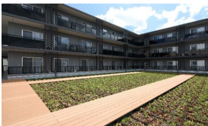
弊社新築施工の一例「サービス付き高齢者住宅」(大阪府大東市)
