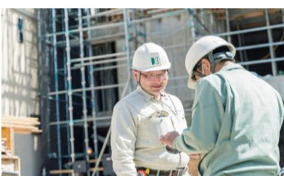
ホテル新築現場での様子。職親雇用者(右)も施工管理の勉強中です
