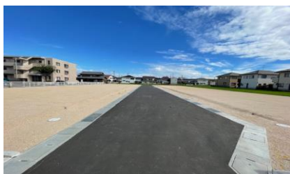
分譲住宅用地造成工事
