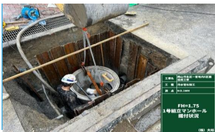
下水道工事の施工の様子です
