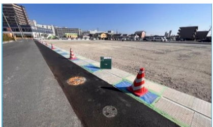
マンション用地の造成工事
