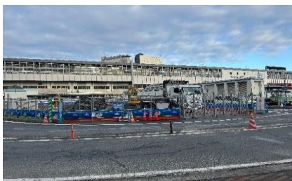
岡山駅で工事の様子です
