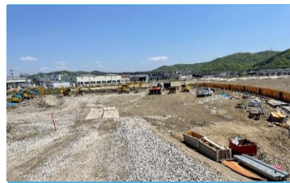
大型の土地の造成工事の様子
