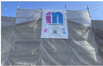
安全第一で作業を行っています
