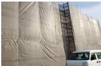
ビルや、工場など大きな建物の塗装も 行います
