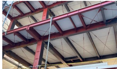
鉄骨工事一式
