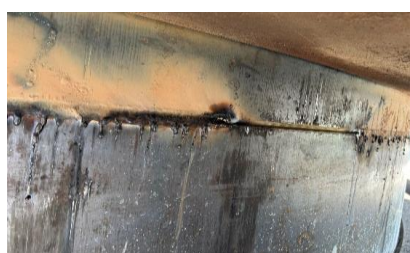
アーク溶接工事
