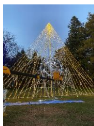
イルミネーション設置工事軽井沢プリンスホテル
