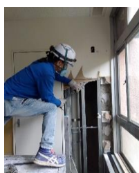
解体工事 ボードあおり
