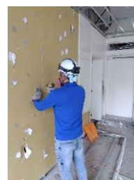
解体工事 ボード びすぬぎ
