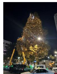
イルミネーション取付工事赤羽駅前
