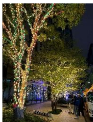
イルミネーション設置工事京橋エドグラン
