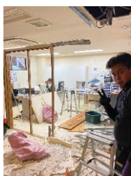
内装解体作業 ぱっちりカメラ目線なのは社長です
