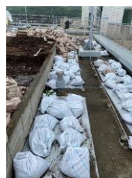
屋上花壇の撤去作業 土がね、多いんですよ
