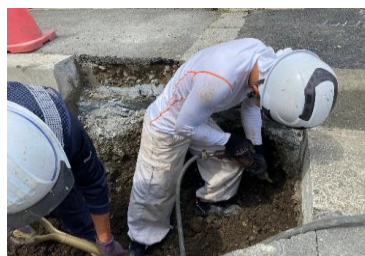
水道工事作業風景 重機で出来ない細かい作業
