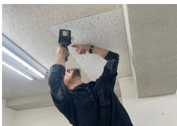
内装作業 天井ボード取付
