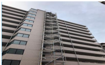
マンション設備工事
