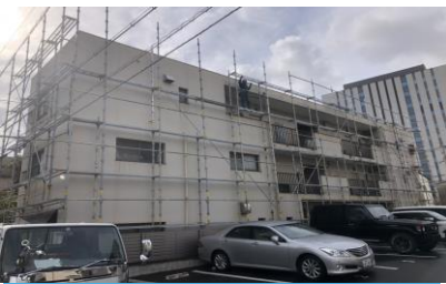
アパートリフォーム 足場
