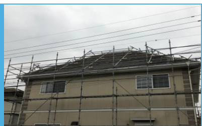
一般住宅改修工事
