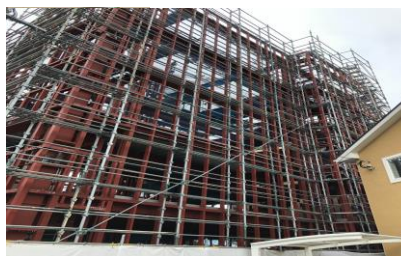
アパート 鉄骨新築足場
