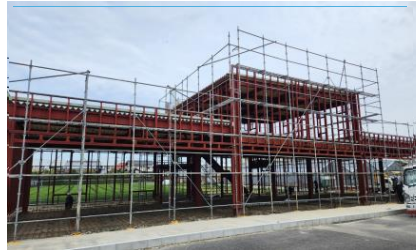
自動車整備工場 鉄骨新築足場
