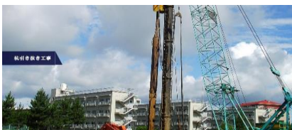
杭引き抜き工事
