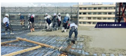
コンクリート打設工事
