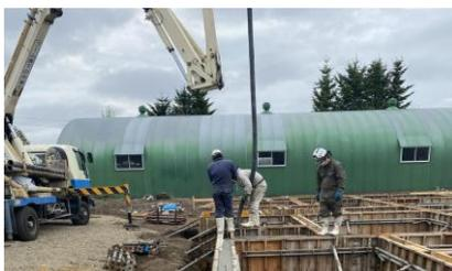
組まれた型枠の中に生コンを流し込む（打設する）のがお仕事です。
