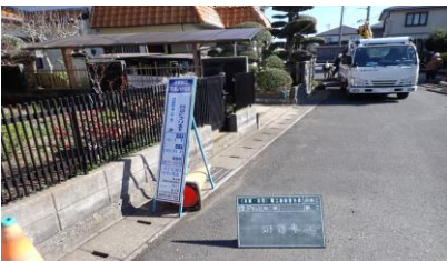
取付管補修工事（汚水・雨水）
