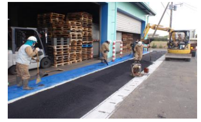
JA山武市〇〇倉庫改修工事
