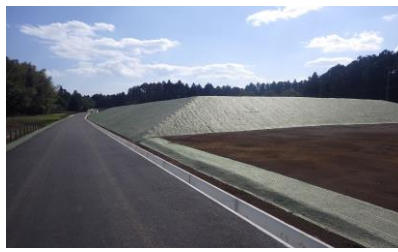
R3圏央道〇〇地区改良その1工事
