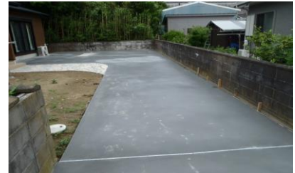
土間コンクリート打設完了
