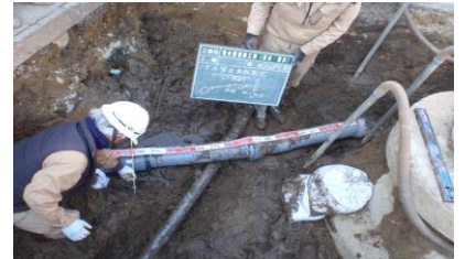
汚水管 出来形測定
