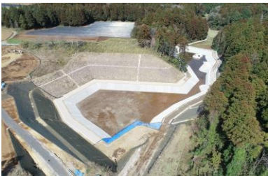
R1圏央道〇〇地区改良工事
