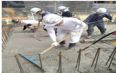
ポンプ車から出てくる生コンを引っ張ります。
