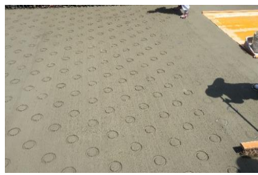
真空コンクリート (リング工法仕上げ)
