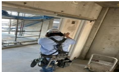
ALCパネル建て込み
