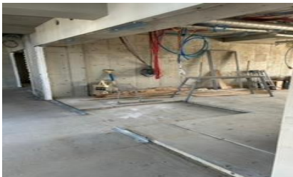
RC躯体に下地金物取付
