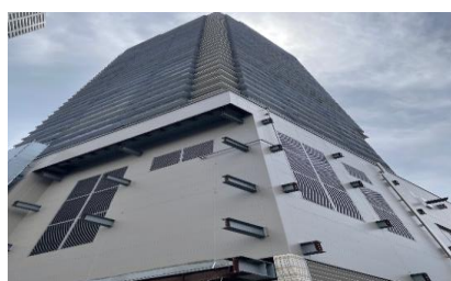
商業ビル工事
