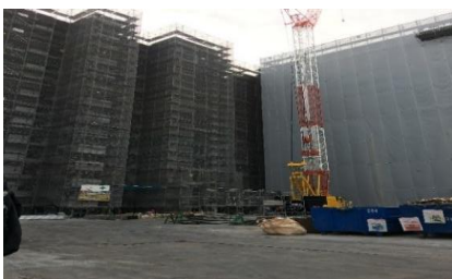
マンション工事
