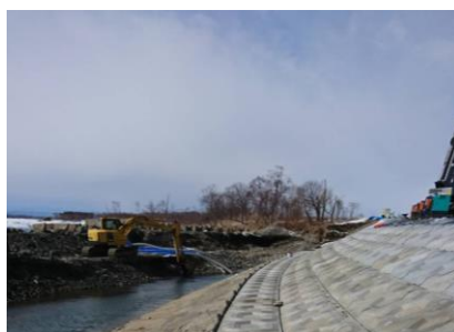
河川堤防工事
