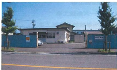
(株)齊藤 本社事務所
