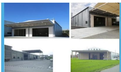
延床1730坪の自社倉庫と 4 531坪の駐車場完備しています
