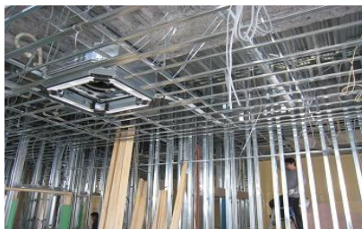
LGS工事壁・天井下地
