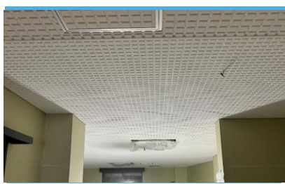
化粧ボード貼貼終わり
