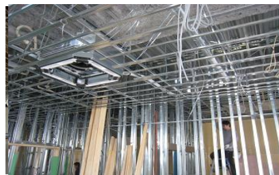
LGS工事壁・天井下地
