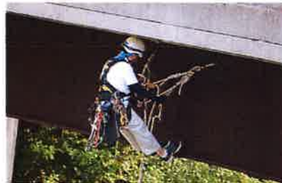
【ロープアクセス工法】足場工事とは違って足場の組立などを行わず、全身ハーネスと2本のロープを用いて高所作業を可能にする工法です。
