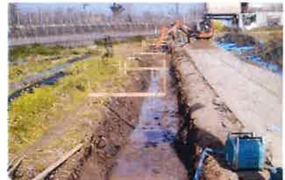
【土木工事】重機などを用いて主に道路補修工事、排水路改修工事等様々な工事を請け負っています。
