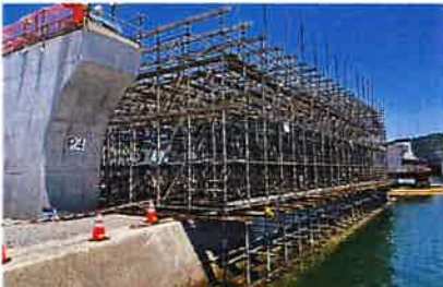
【足場仮設工事】一般の住宅からビル・マンションや大型の商業施設や公共施設などあらゆる建築物に対する足場工事を請負っています。
