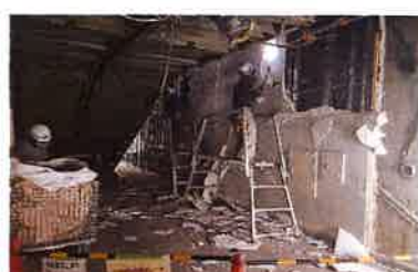
解体作業②
