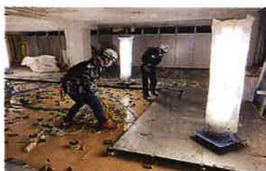
解体作業①
