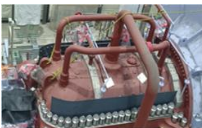
断熱する前のタービン本体
