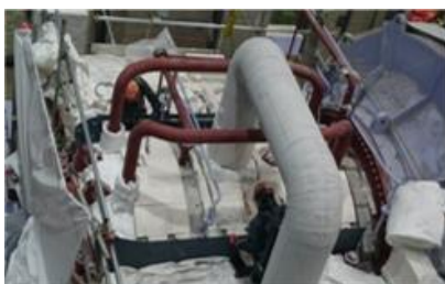
タービン本体の施工中
