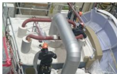
タービン本体の仕上げ施工中
