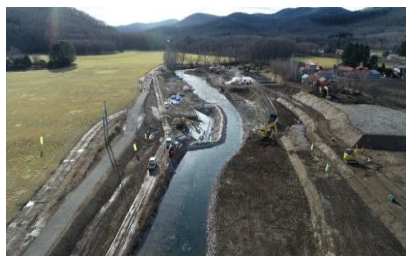
河川工事現場風景
