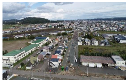
道路工事現場風景
