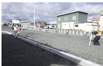
道路工事現場風景
