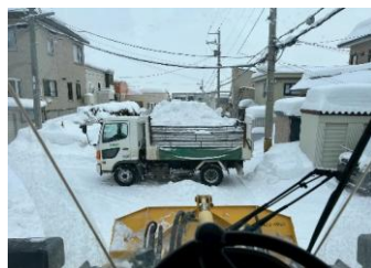
民間の除雪にて排雪除雪作業
