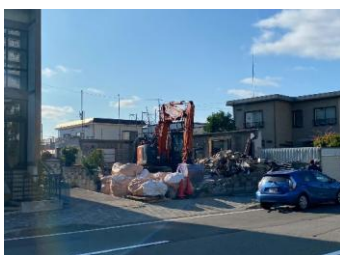
解体事業にて機械による解体作業
