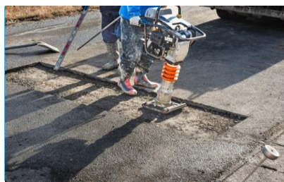
道路補修作業
