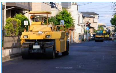
生活道路舗装作業風景
