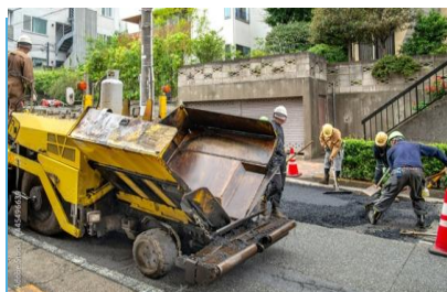
舗装材を機械で流し、整える作業
