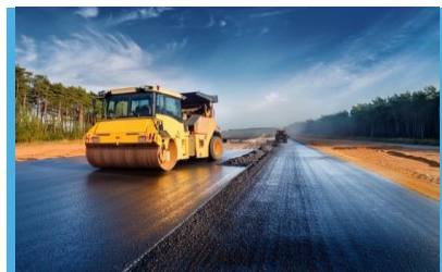
道路転圧風景
