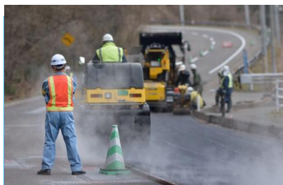
舗装した道路を敷き固める作業
