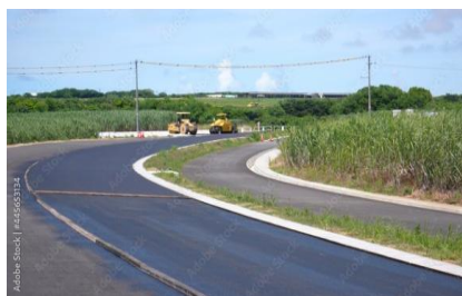
施工後の新しい道路風景
