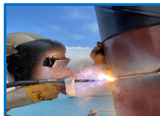
鋼管杭溶接 資格と技術が伴います
