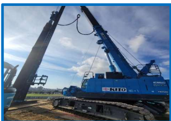
既存杭引抜工 75 t テレスコクレーン
