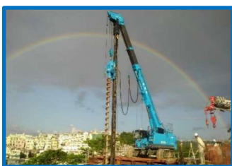
親杭プレボーリング、仮設栈橋工 雨上がりに虹
