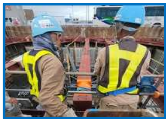
切梁・腹起し設置、職長の指示のもと に手元作業から職人へ成長できる
