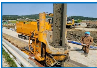
鋼矢板圧入 オペレーターがリモコンで操作します
