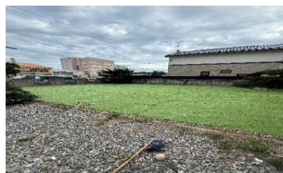
外構工事 整地、人工芝
