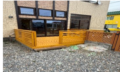
外構工事 ウッドデッキ
