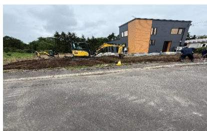
外構工事 舗装工事
