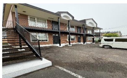
リフォーム 外壁張替
