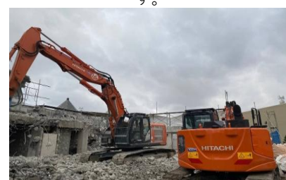
R C造解体工事
