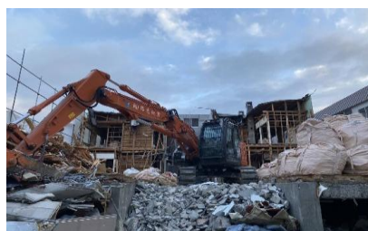
木造住宅解体工事
