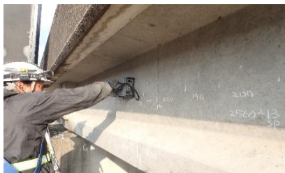
作業風景 (橋梁点検作業)
