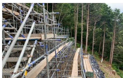
作業風景 (足場工)
