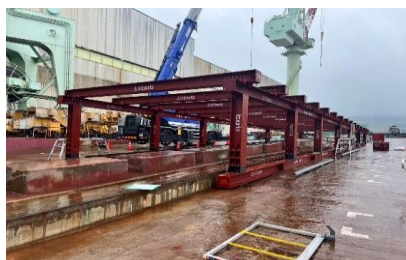
作業風景 (鉄骨工)
