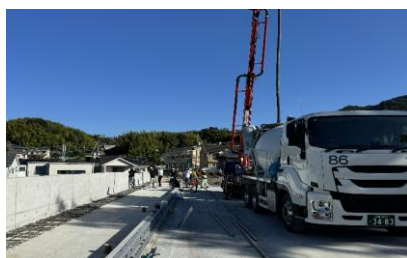
2024年 公共工事 橋梁・歩道・転落防止新設工事
