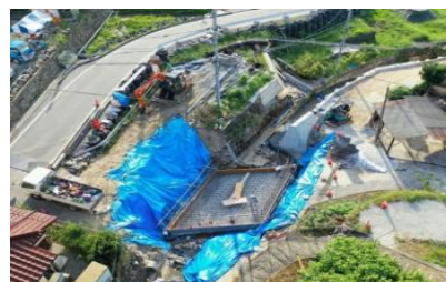
2023年災害復旧工事 橋脚基礎施工状況写真
