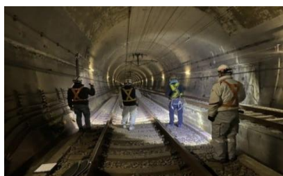
2023年度 鉄道土木 JR西日本新幹線トンネル内
