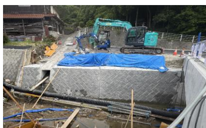
2025年 公共工事 ブロック積工施工状況
