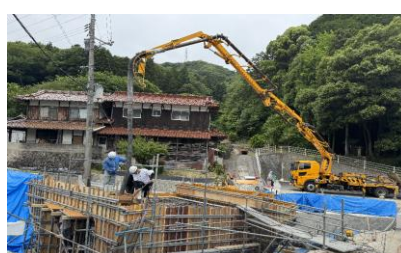
2025年 公共工事 ボックスカルバート施工状況
