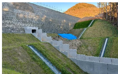
大型水槽、落差排水路完成。
