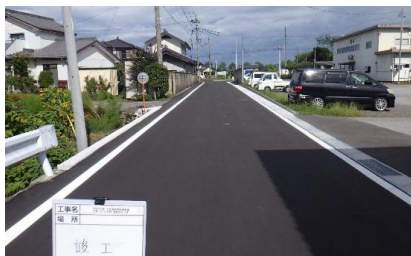
昼間、夜間道路改良工事完成。
