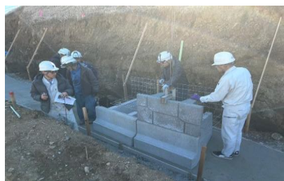
垂直擁壁組み立て。
