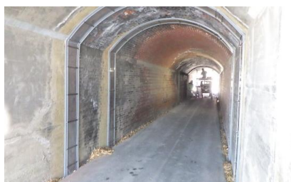
トンネルの漏水対策補修工事完成。
