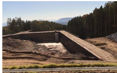
補強土壁Wウォール完成。
