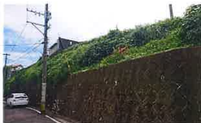
草刈除草作業
