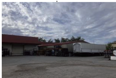
第二ヤード トレーラーのシャッシー駐車場
