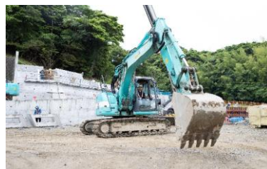
地面を掘削するため 重機を使用します。
