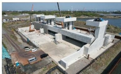
県内最大級の水門工事に携わり 施工を行いました！
