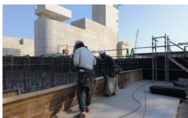
コンクリートを止める型枠を 建てています。
