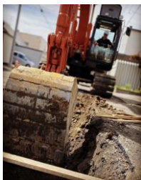
道路改良工事
