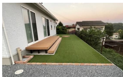
外構工事 完成
