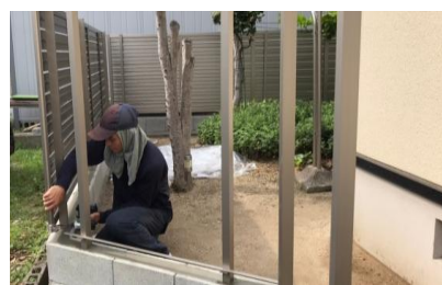
外構工事 作業風景
