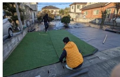
外構工事 作業風景
