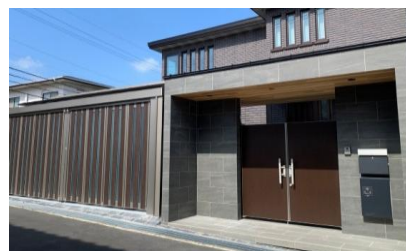
外構工事 完成
