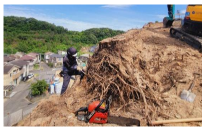
法面工事 作業風景
