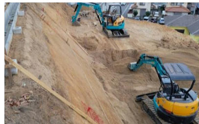
法面工事 作業風景
