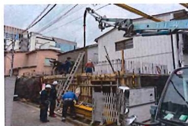
求人③【コンクリート圧送工】
