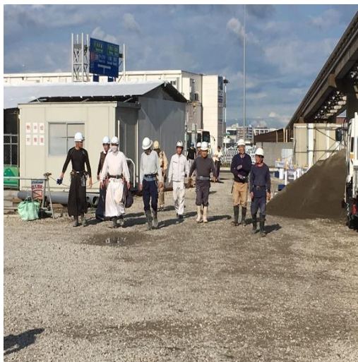
作業現場風景
