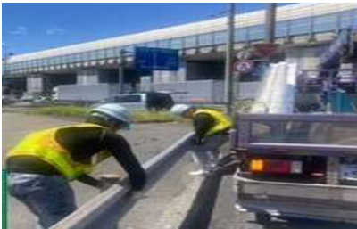
ガードレール工事
