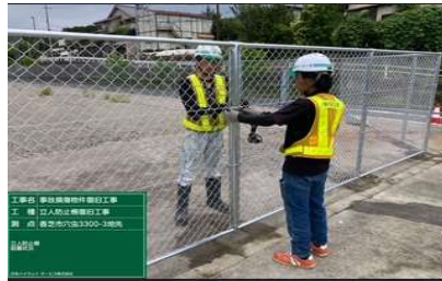
フェンス工事
